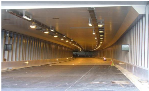
Рис. 7. Тоннель в подземном Комплексе
