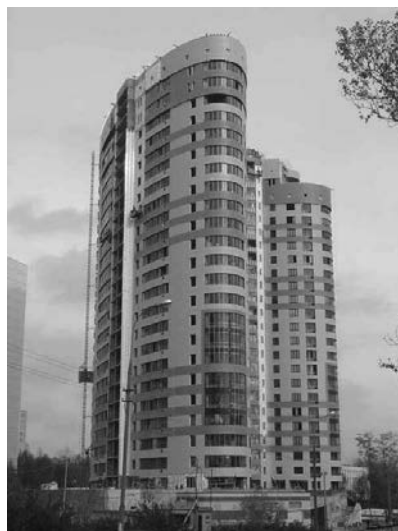
Рис. 5. Жилой комплекс на ул. Давыдовская, д. 19А, вид после окончания строительства.
