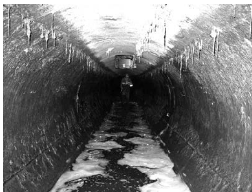
Рис 8. Монтаж измерительной аппаратуры для геомониторинга коллектора
