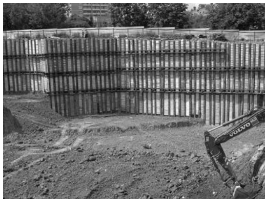
Рис.3. Для снижения стоимости строительства вместо анкеров верхнего яруса иногда предусматривают растяжки. Эффективность такого решения "нулевая", что хорошо видно на фотографии. Растяжка не имеет натяжения, огибает колодец. До того как растяжки включатся в работу, вся нагрузка будет восприниматься ниже расположенными грунтовыми анкерами. Перегруженные анкера должны выдержать дополнительную нагрузку, тогда зачем растяжки?
