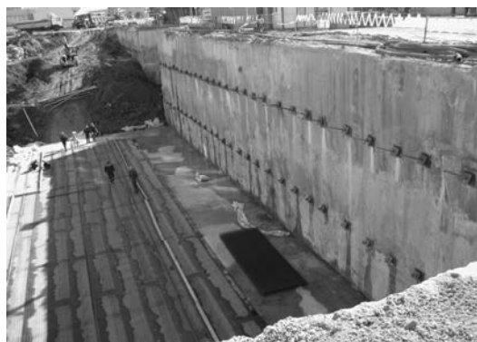
Рис. 7. Закрепленная анкерными сваями ограждающая стена котлована подземного терминала АВК-1.
