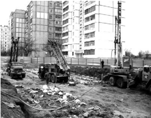
Рис. 7. Общий вид установок для устройства ГЦЭ
