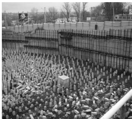
Рис. 9. Ростов-на Дону, на пересечении улиц Красноармейской и Сиверса в откосе глубиной до 14 м был вырыт котлован, борта которого закреплены грунтовыми анкерами. После чего в котловане было забито 2600 свай длиной по 12 м (общее свайное поле представлено на трех фотографиях).
