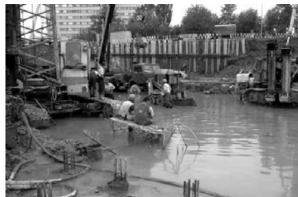
Рис. 6. Изготовление свай-РИТ при строительстве жилого комплекса (ул. Давыдовская, вл. 19А).
