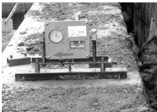
Рис.6. Уклономер, установленный на «стене в грунте»
