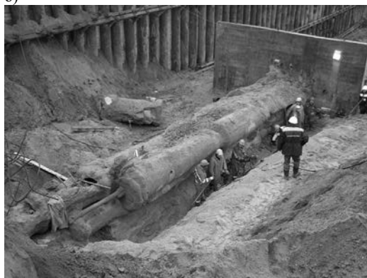
Рис. 3. Укрепление грунтов струйной цементацией на опытном участке: а) бурение и инъекция, б) вид укрепленного массива
