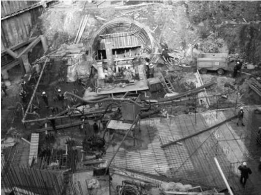
Рис.1. Общий вид строящегося тоннеля и подземного вестибюля станции метро «Маяковская»
