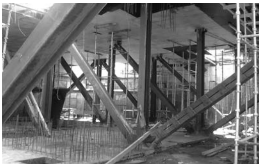
Рис. 4. Крепление котлована для здания «Бизнес Центр Астана».
