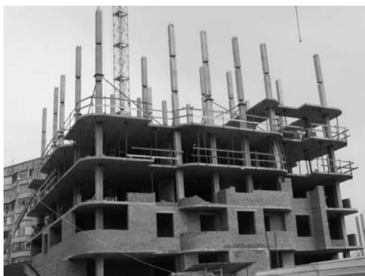
Рис.2. Процесс строительства жилого дома с каркасом «КУБ-2,5»
