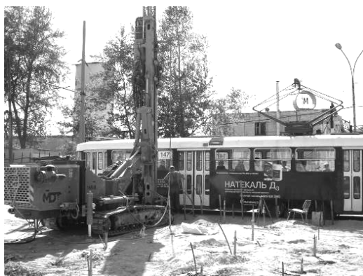
Рис.16. Армирование трещиноватого скального массива при строительстве ст. Чкаловская метрополитена в Екатеринбурге
