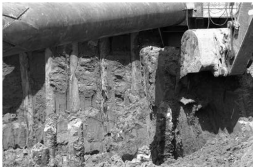
Рис. 2. Ново-Даниловская набережная, д. 8. Устройство свай в котловане, закреплённом распорками, выполнялось с уровня дна промежуточного котлована, до устройства распорок. Объём бросового бурения и бетона на этом объекте составил 3560 м и 356 м 3 соответственно. Фото вверху – разработка грунта под распорками из труб, на переднем плане видны верхние части свай, ломаемые экскаватором. Фото внизу – вид свайного поля, изготовленного со дна промежуточного котлована, после разработки грунта.
