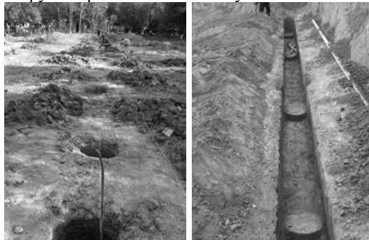
Рис.5. Процесс бурения, заливки бетона в шурфы, и общий вид ВАЭ, вдоль вскрытой траншеи.
