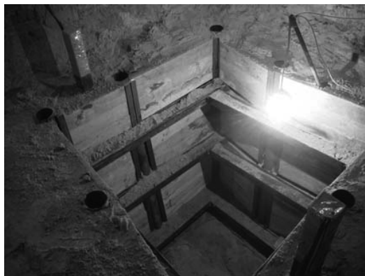
Рис. 11 Вид опытного шурфа
