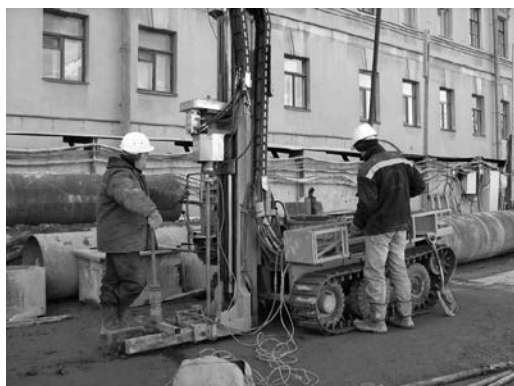
Рис. 2. Погружение зонда на площадке № 3
