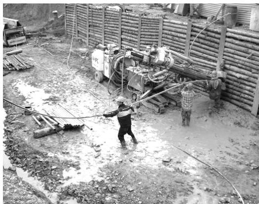
Рис.2. Установка фибerglassового анкера в скважину, г. Екатеринбург
