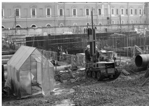
Рис. 1. Статическое зондирование грунтов на площадке № 1
