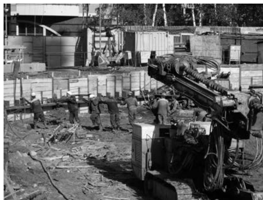
Рис.8. Ленинский пр-т, д. 114, Монтаж анкерной тяги длиной 22 м в верхнем ярусе анкеров, будущего котлована глубиной 14 м.
