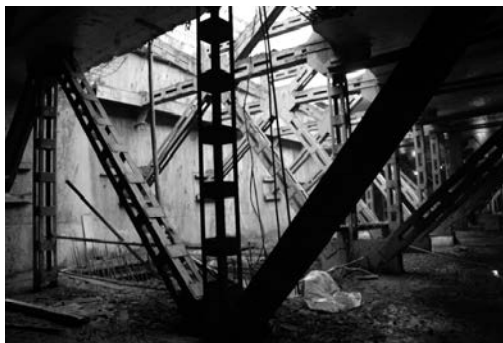
Рис. 3. Временные инвентарные несущие элементы пространственной распорной конструкции при строительстве многоярусного подземного гаража на Тургеневской площади.
