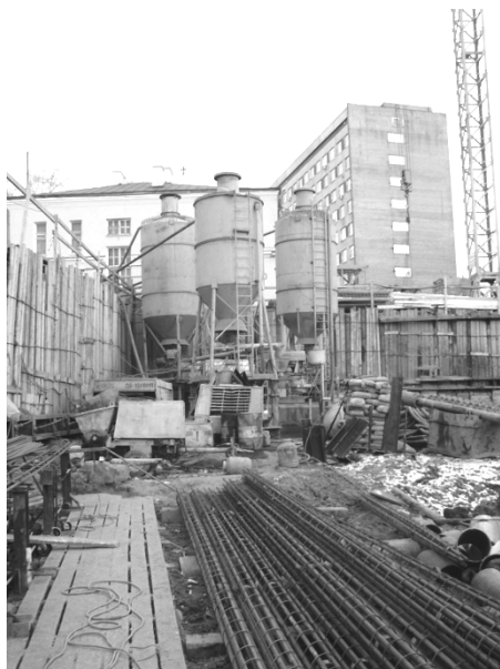
Рис. 10. Бетоносмесительный завод в котловане (Семеновский пер., д. 21).
