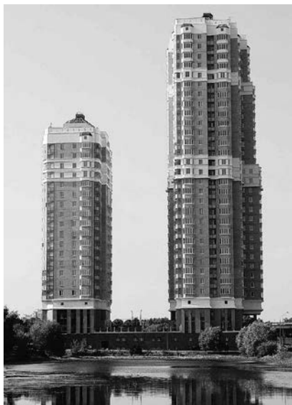
Рис. 1. Жилой комплекс (проспект Вернадского, 37), фото со стороны пруда.
