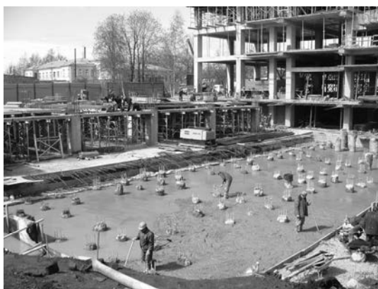
Рис. 4. Бетонирование фундаментной плиты 13-ти этажного корпуса
