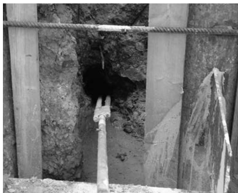
Рис.10. Вид анкерной тяги временного анкера после её установки в скважину, верхний пояс ещё не смонтирован (забирка разобрана для фотографирования).
