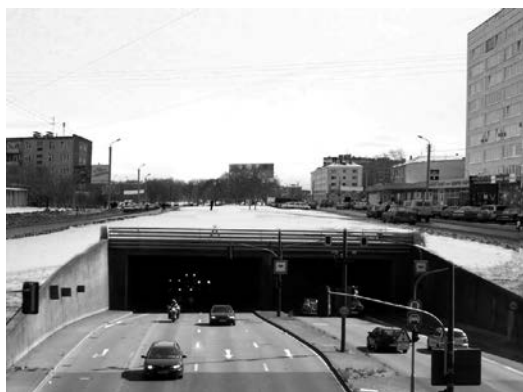
Фото 5. Общий вид портала транспортного тоннеля по улице Курчатова перед улицей Воровского.
