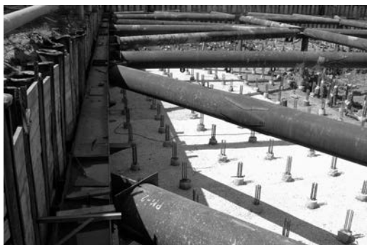
Рис. 2. Ново-Даниловская набережная, д. 8. Устройство свай в котловане, закреплённом распорками, выполнялось с уровня дна промежуточного котлована, до устройства распорок. Объём бросового бурения и бетона на этом объекте составил 3560 м и 356 м 3 соответственно. Фото вверху – разработка грунта под распорками из труб, на переднем плане видны верхние части свай, ломаемые экскаватором. Фото внизу – вид свайного поля, изготовленного со дна промежуточного котлована, после разработки грунта.
