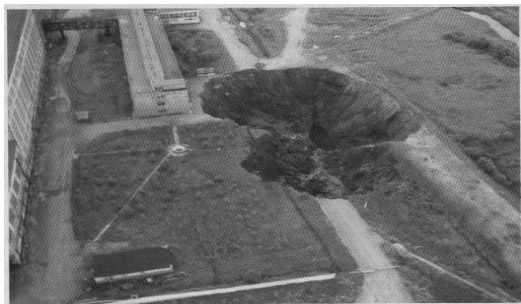
Рис. 9. Провал над горными выработками на руднике в г. Березняки, 2007 г., рядом со зданием заводоуправления
