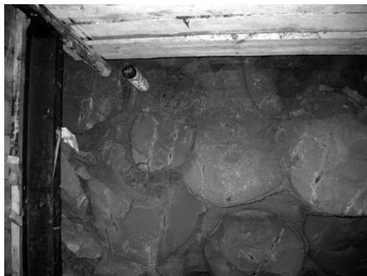
Рис. 6. Укрепление грунтов сбойки №5 грунтоцементными сваями
