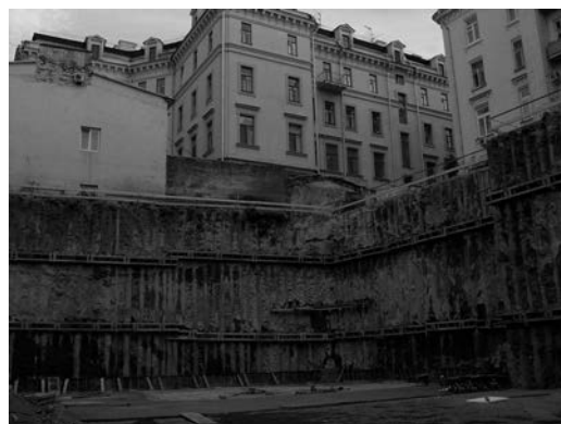
Рис.6. Расстояние до зданий на отдельных участках котлована было менее 1 м.
