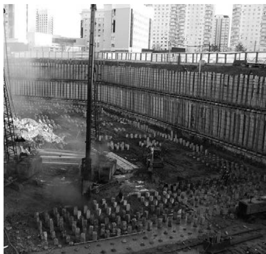
Рис.7. Ул. Академика Анохина, д. 26. В котловане глубиной до 15 м идет забивка свай, борта закреплены грунтовыми анкерами-РИТ. Корни нижнего яруса в разжижаемых супесях.
