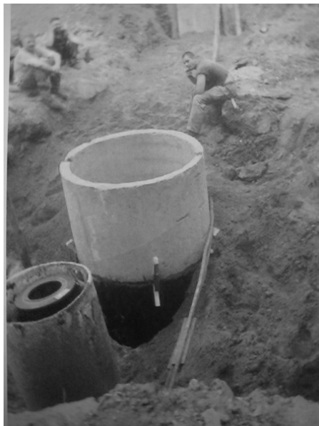
Рис.3. Для снижения стоимости строительства вместо анкеров верхнего яруса иногда предусматривают растяжки. Эффективность такого решения "нулевая", что хорошо видно на фотографии. Растяжка не имеет натяжения, огибает колодец. До того как растяжки включатся в работу, вся нагрузка будет восприниматься ниже расположенными грунтовыми анкерами. Перегруженные анкера должны выдержать дополнительную нагрузку, тогда зачем растяжки?
