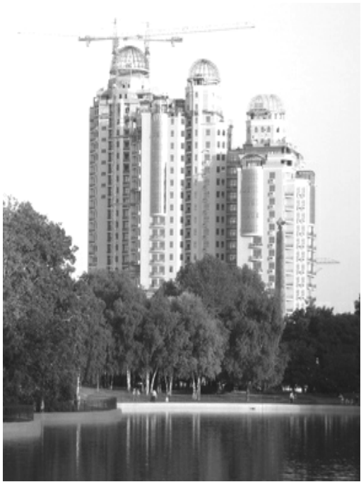
Рис. 5. Общий вид зданий, возведенных на понтических известняках по ул. Генуэзской, 1 в г. Одессе. Два дома справа - на естественном основании, а слева - на буронабивных сваях.
