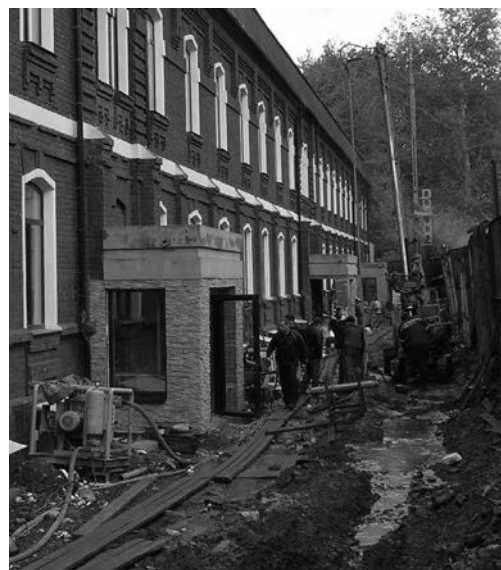
Рис. 1. Устройство отсечного экрана из грунтоцементных свай вблизи здания по адресу: ул. Грузинский вал, д. 11, стр.5.
