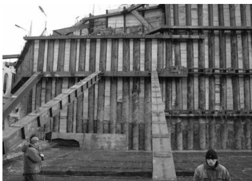
Рис. 1. Пр-т Маршала Жукова, подкосы в котловане глубиной 12 м.
