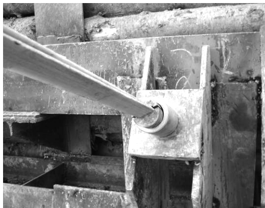
Рис.18. Крепление фиберглассового анкера к металлическому обвязочному поясу
